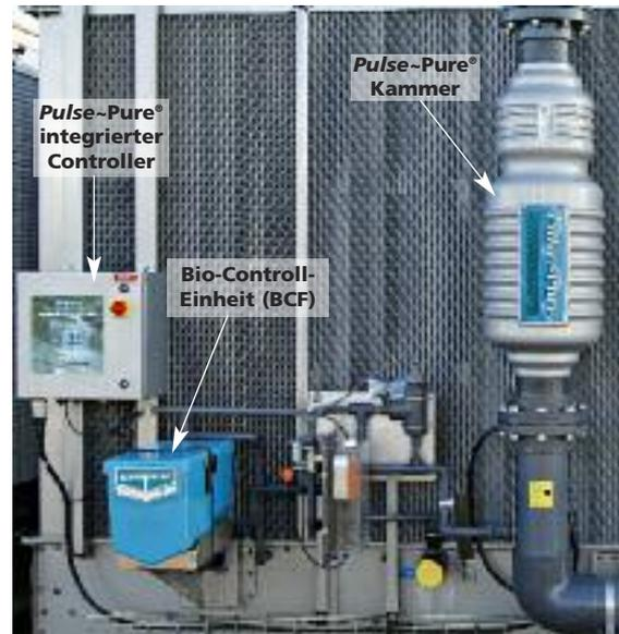
EVAPCO's **Pulse~Pure® PLUS** Wasseraufbereitungssystem verwendet impuls-gesteuerte, elektronische Magnetfeld-technik um eine umweltfreundliche und verantwortungsvolle Alternative für die Wasseraufbereitung bei Verdunstungs-kühlsystemen zu bieten. Das **Pulse~Pure® PLUS** System sendet kurze, hochfrequente Stöße geringer elektro-magnetischer Felder an das Umlaufwasser im Aggregat.
