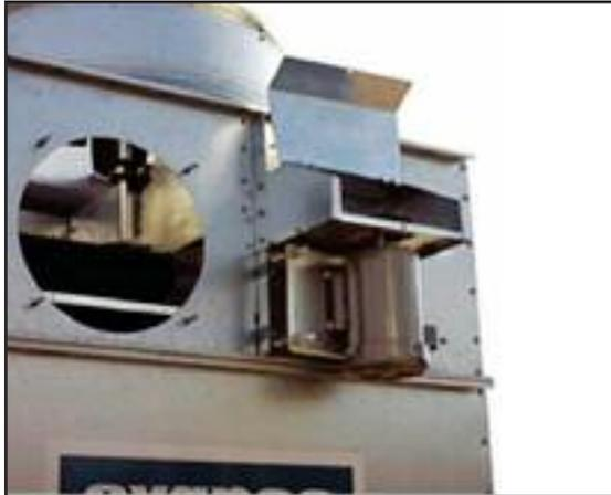
Außen montierter Motor (mit aufklappbarer Haube)
