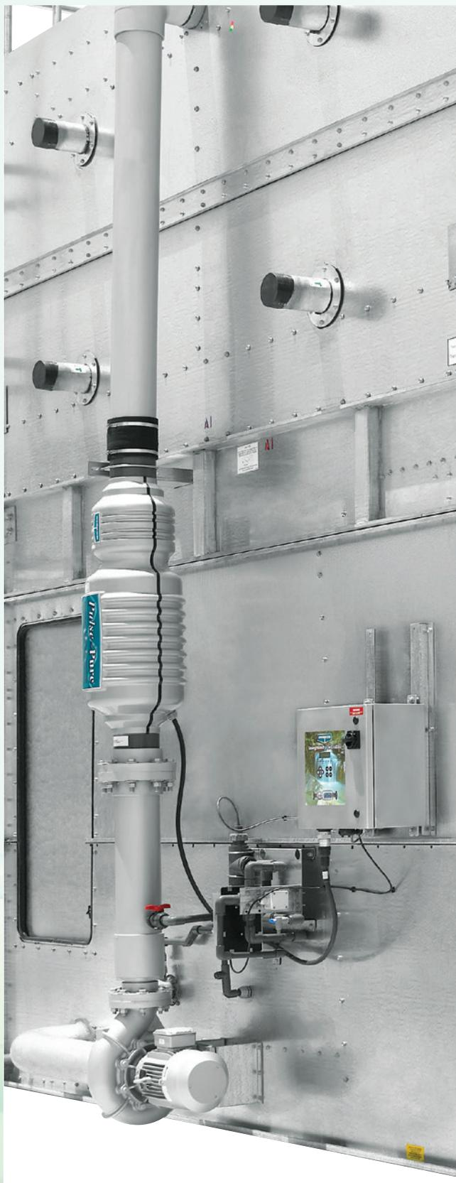
Der eco-LSWE und eco-LRWB ist mit EVAPCO's werkseitig montierten Wasseraufbereitungssystemen Smart Shield® oder Pulse~Pure® lieferbar. Beide Systeme optimieren die Wärmeübertragungsleistung und verlängern die Lebensdauer Ihres Aggregates.
