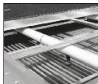
Tropfenabscheider wurde entfernt für die Inspektion des Rohrschlangenwärmetauschers
