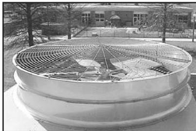
Sound“ Ventilator lässt sich der Schalldruckpegel des Aggregates, je nach ausgewähltem Typ und Position der Schallbestimmung, um einen Wert zwischen **4 dB(A) und 7 dB(A)** reduzieren. Beim Betrieb dieser hocheffizienten Axialventilatoren ergeben sich keine Einbußen auf die thermische Leistung.
