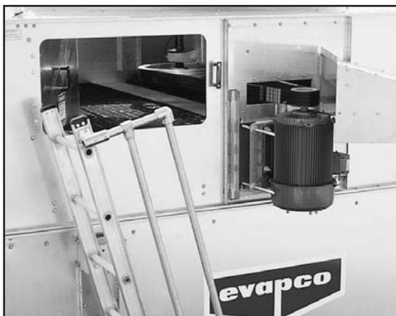
Außen montierter Motor (mit Leiter als Option)
