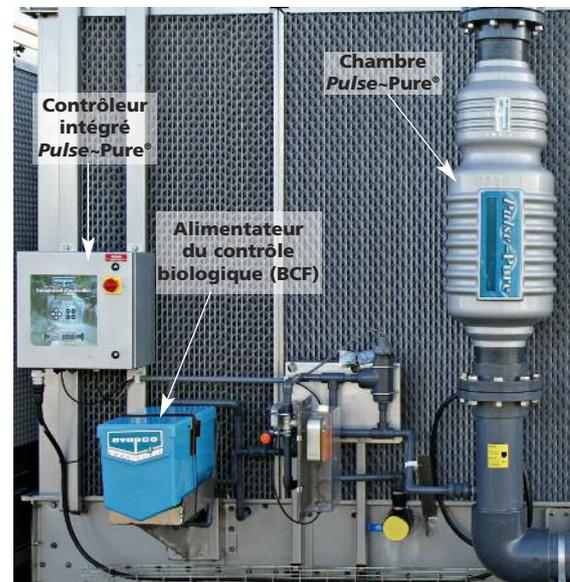
Le système de traitement des eaux **Pulse~Pure® PLUS** d'EVAPCO utilise la technologie des champs électriques pulsés pour fournir une alternative écologique au traitement des eaux dans l'équipement de refroidissement par évaporation.
