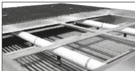
Eliminateurs de gouttes démontés pour l'inspection de la distribution d'eau
