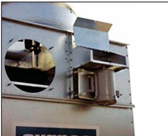
Montaggio esterno del motore
