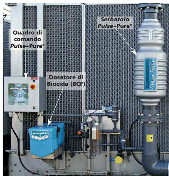
Il sistema di trattamento di acqua EVAPCO **Pulse~Pure**® PLUS utilizza la tecnologia dei campi elettrici pulsanti per fornire un'alternativa ecologica e responsabile per il trattamento dell'acqua nei sistemi di raffreddamento evaporativo. **Pulse~Pure**® PLUS utilizza campi elettrici ad alta frequenza e bassa potenza nell'acqua di ricircolo dell'eco-ATWB-H.
