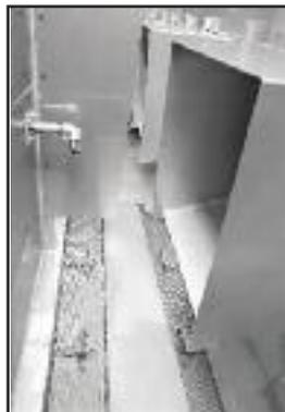
Il fondo, opportunamente inclinato verso la connessione di scarico, è progettato per raccogliere le impurità accumulate e può essere facilmente pulito con un getto d'acqua. I filtri possono essere facilmente estratti per la pulizia periodica.
