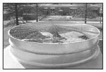
falls für geräuschsensible Anwendungen mit einer breiten Flügelgeometrie versehen. Die Flügel sind aus Aluminium gefertigt mit einer Nabe aus Stahl. Mit dem "Low
