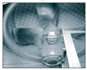
Ventilatorsystem mit Direktantrieb
